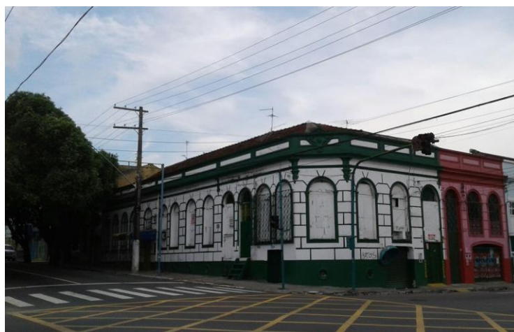
Figura 3: Residência de Luiz Facundo do Valle, na Rua Epaminondas, próximo ao Rio Negro Clube.
