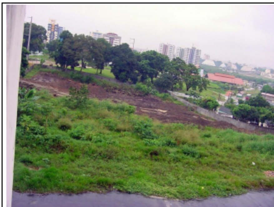
Figura 09 – Início das obras de prolongamento da Rua Maceió, utilizando terreno dos fundos da FAK.
